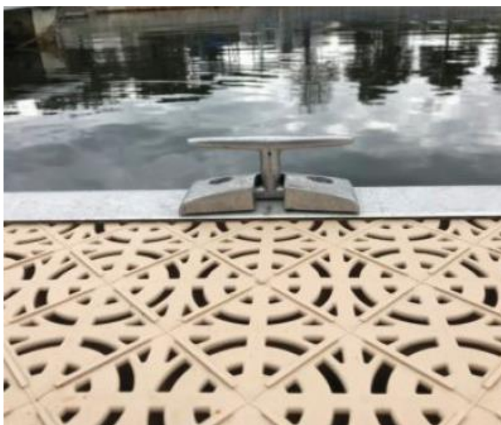
Detalhe da estrutura em alumínio e piso antiderrapante Disponível em: www.poralu.com
