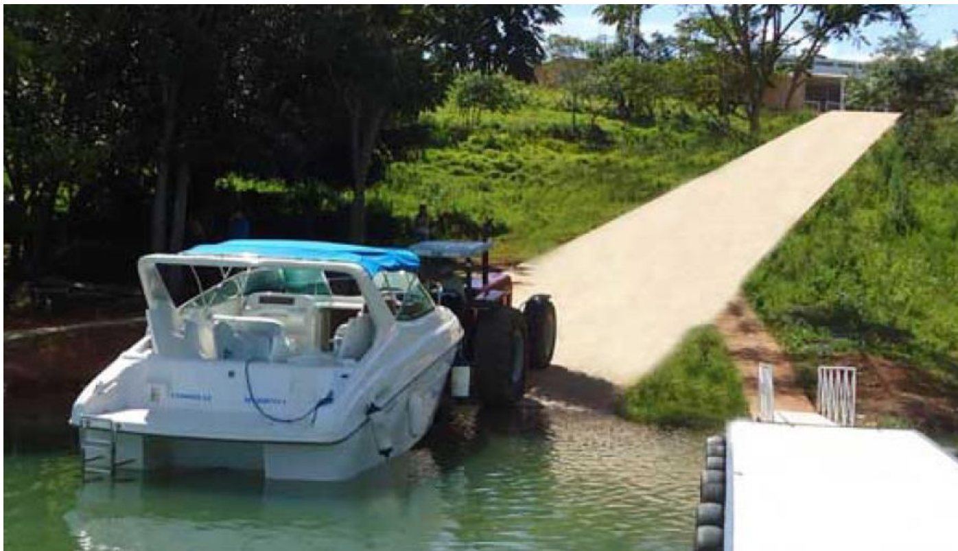
Rampa e píer Largo das Escarpas- MG. Disponível em: https://www.marinaescarpas.com.br/
