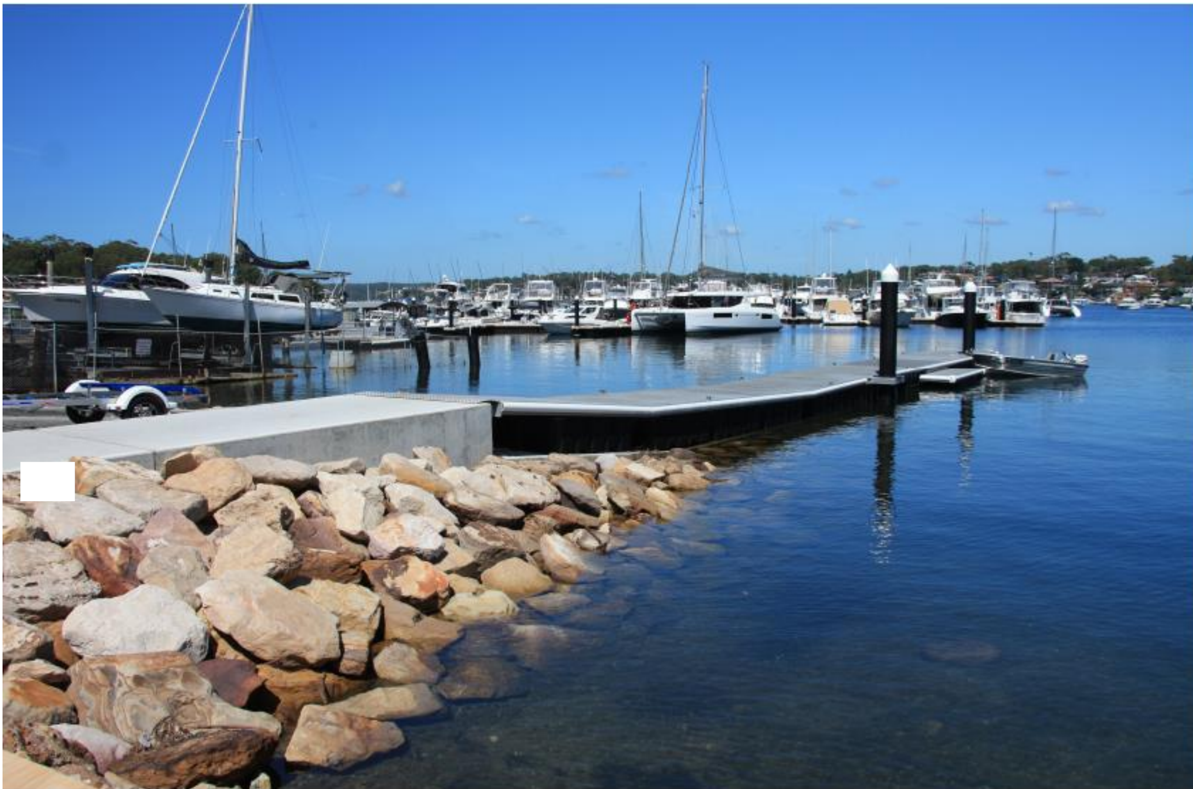
Rampa Náutica de lançamento Cronulla Boat Ramp, Gunnamatta Bay Disponível em: http://www.sutherlandshire.nsw.gov.au/
