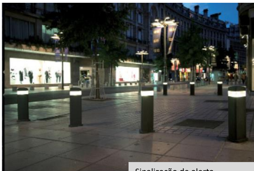
Sinalização de alerta
