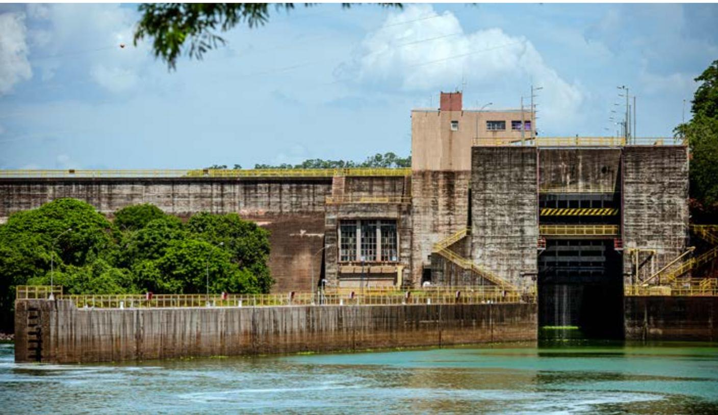
Anexa à Usina Hidrelétrica da AES, com elevador fluvial, traz inúmeros visitantes para a eclusagem. A eclusa permite a transposição do desnível do Rio Tietê por meio de uma câmara de concreto com 142m de comprimento
