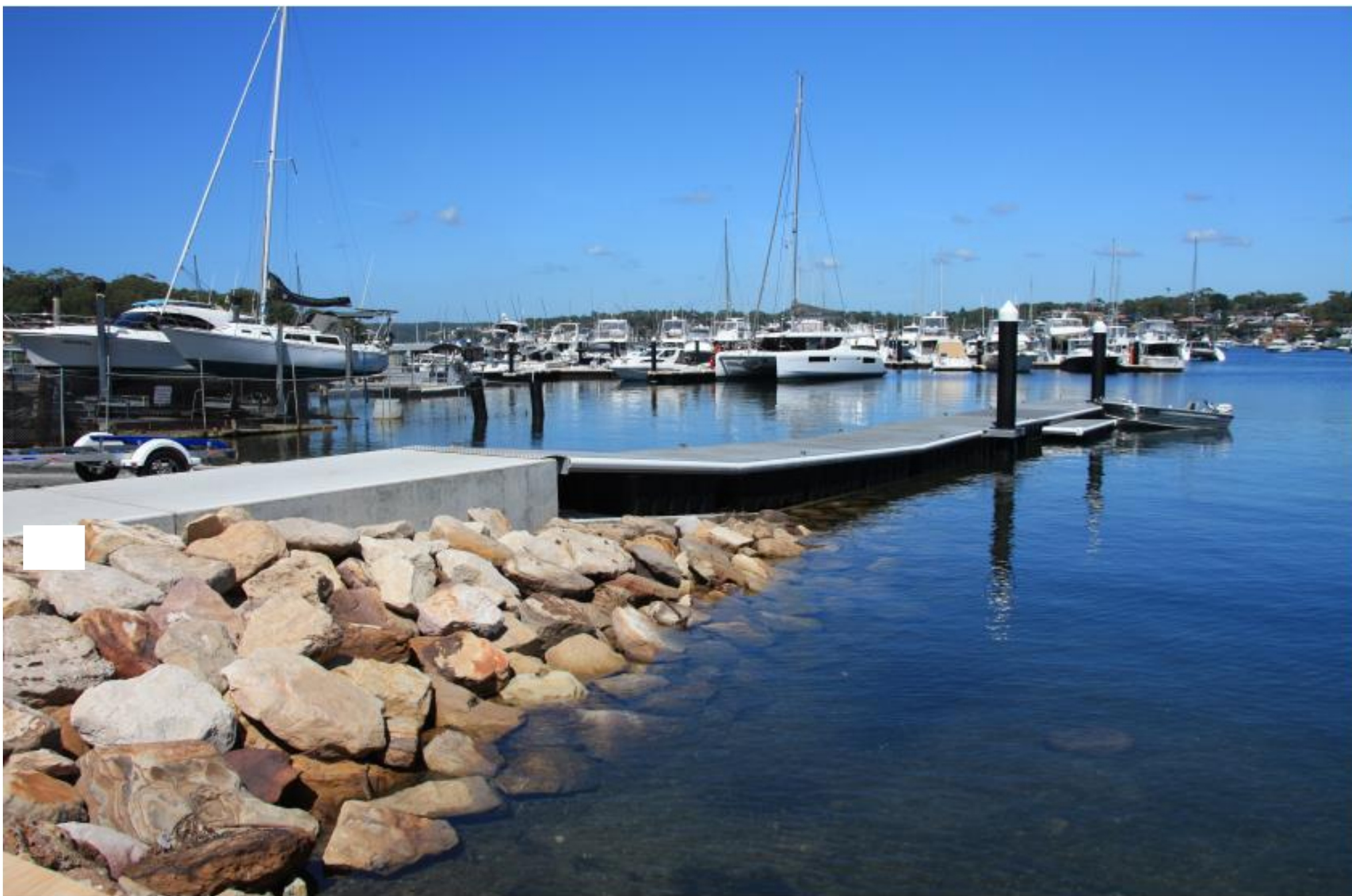
Rampa Náutica de lançamento Cronulla Boat Ramp, Gunnamatta Bay Disponível em: http://www.sutherlandshire.nsw.gov.au/
