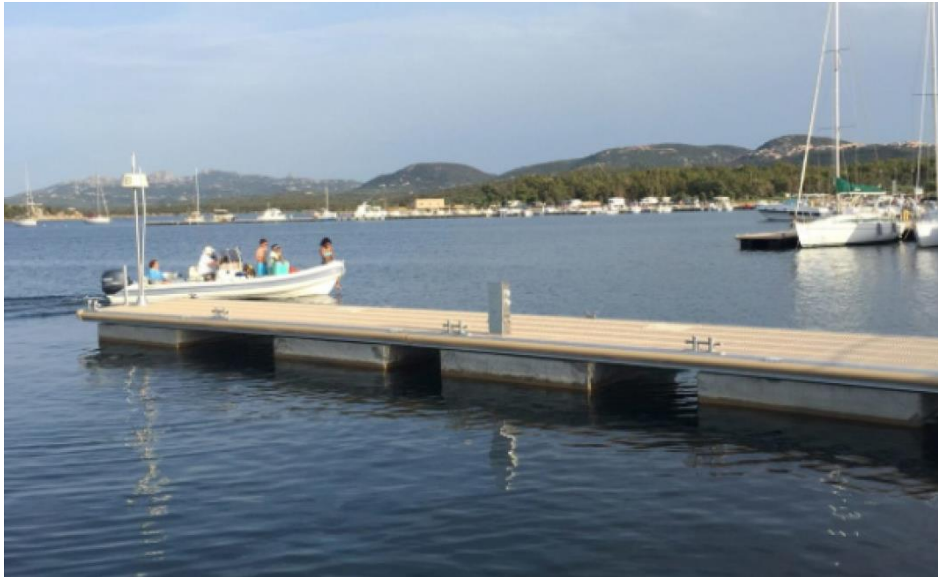
Pier flutuante Disponível em: www.poralu.com
