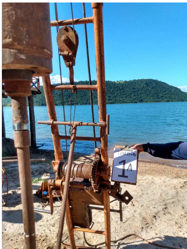
Figura 2: Execução do furo de sondagem SP-01A
