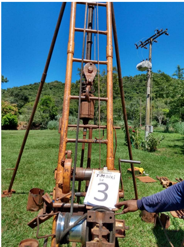
Figura 5: Execução do furo de sondagem SP-03
