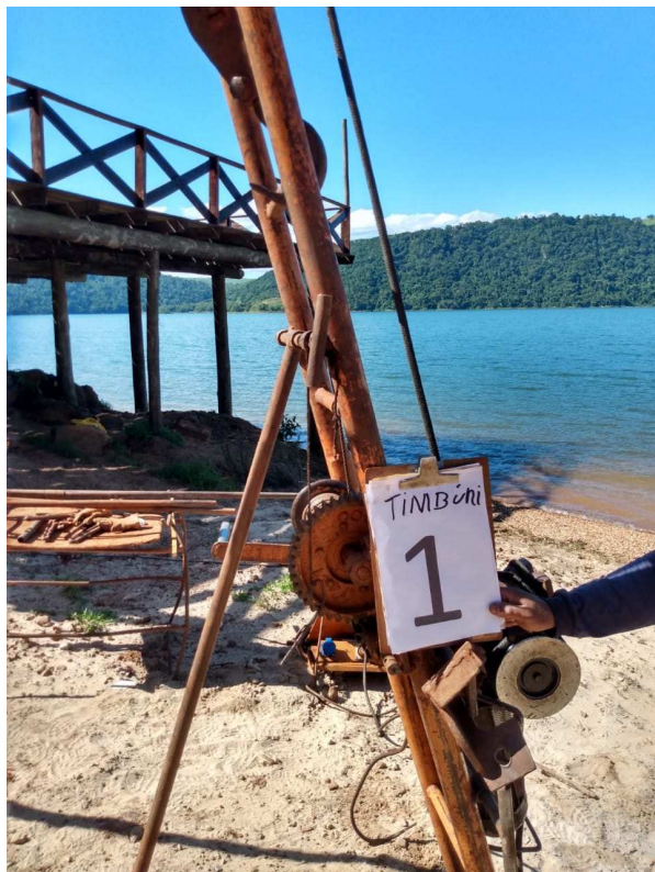
Figura 1: Execução do furo de sondagem SP-01
