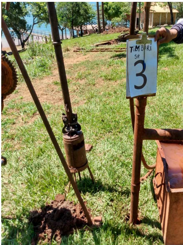
Figura 6: Execução do furo de sondagem SP-03A
