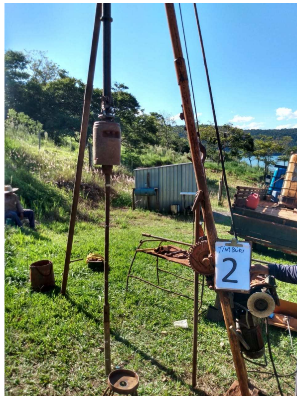
Figura 3: Execução do furo de sondagem SP-02
