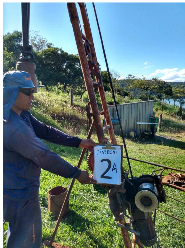
Figura 4: Execução do furo de sondagem SP-02ª
